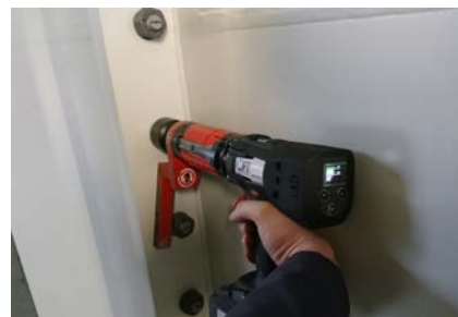
Vertikalflanschverschraubung im Turm mit sensorgesteuertem Akkuschauber MAD 7-S.
