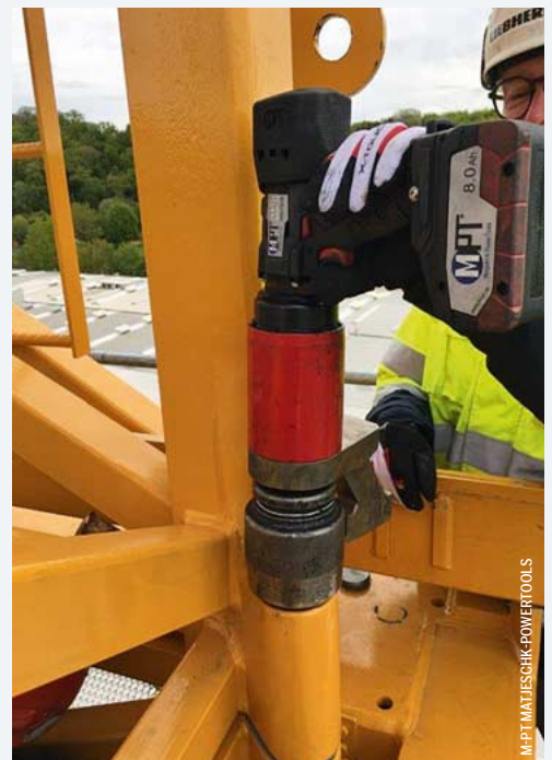
Montage eines Turmdrehkrans mit dem akkubetriebenen Drehmomentschrauber MAD (MB-RAD) 7000.
